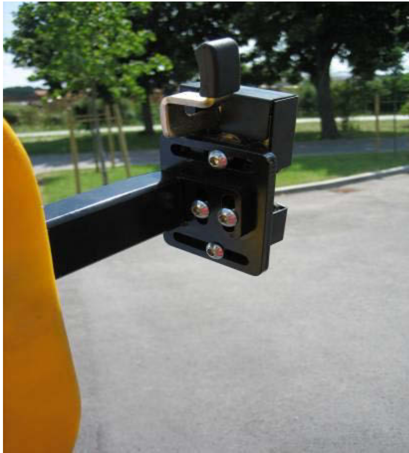
mögliche Feineinstellung Schloss / Schließbolzen
